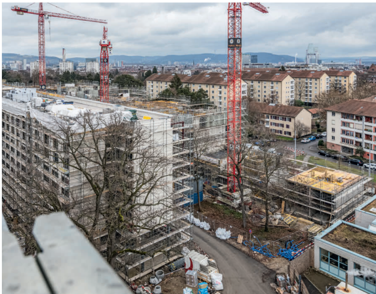
Blick auf die Westfeld-Baustelle im Januar: Die ersten Wohnungen werden Ende 2022 bezugsbereit sein.
