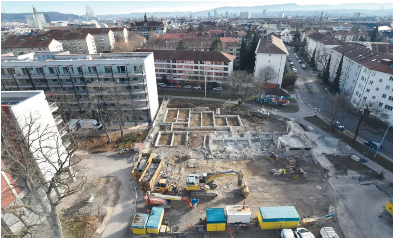
Das Teilareal der zweiten Bauetappe nach Abriss des Bestandsgebäudes (31. Dezember 2023)
