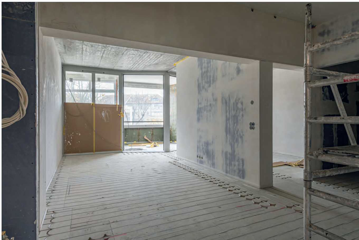
Im Schiff entstehen Wohnungen mit dem besonderen Merkmal der gefalteten Fassade auf der Südseite, die spezielle Innenräume schafft.
