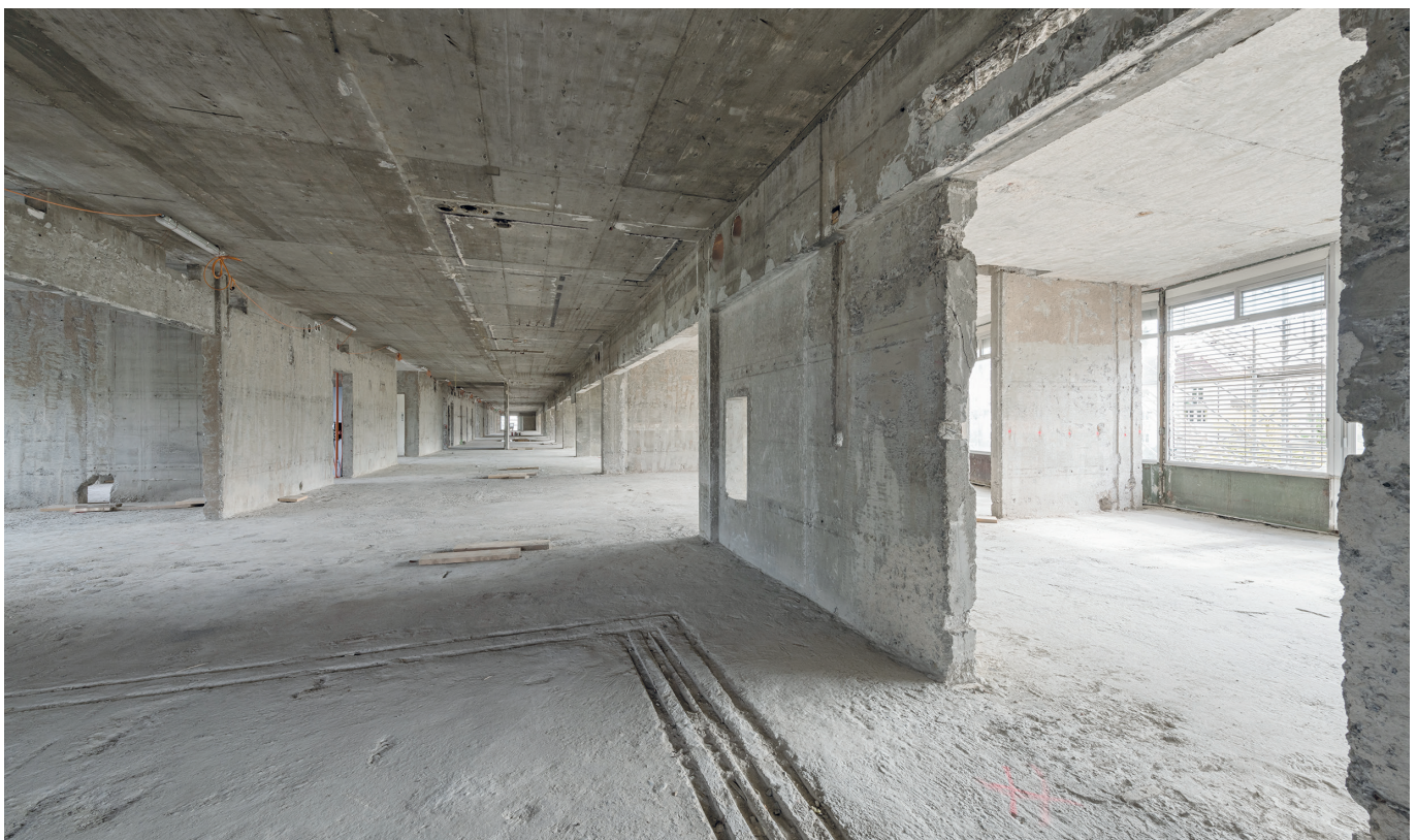
Nach Rückbau freigelegte Betonstruktur des ehemaligen Spitalgebäudes.
