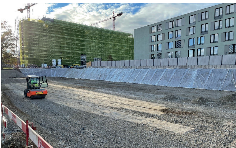
Der Aushub für die Neubauten und die Einstellhalle erfolgte plangemäss bis Ende Januar 2021.
