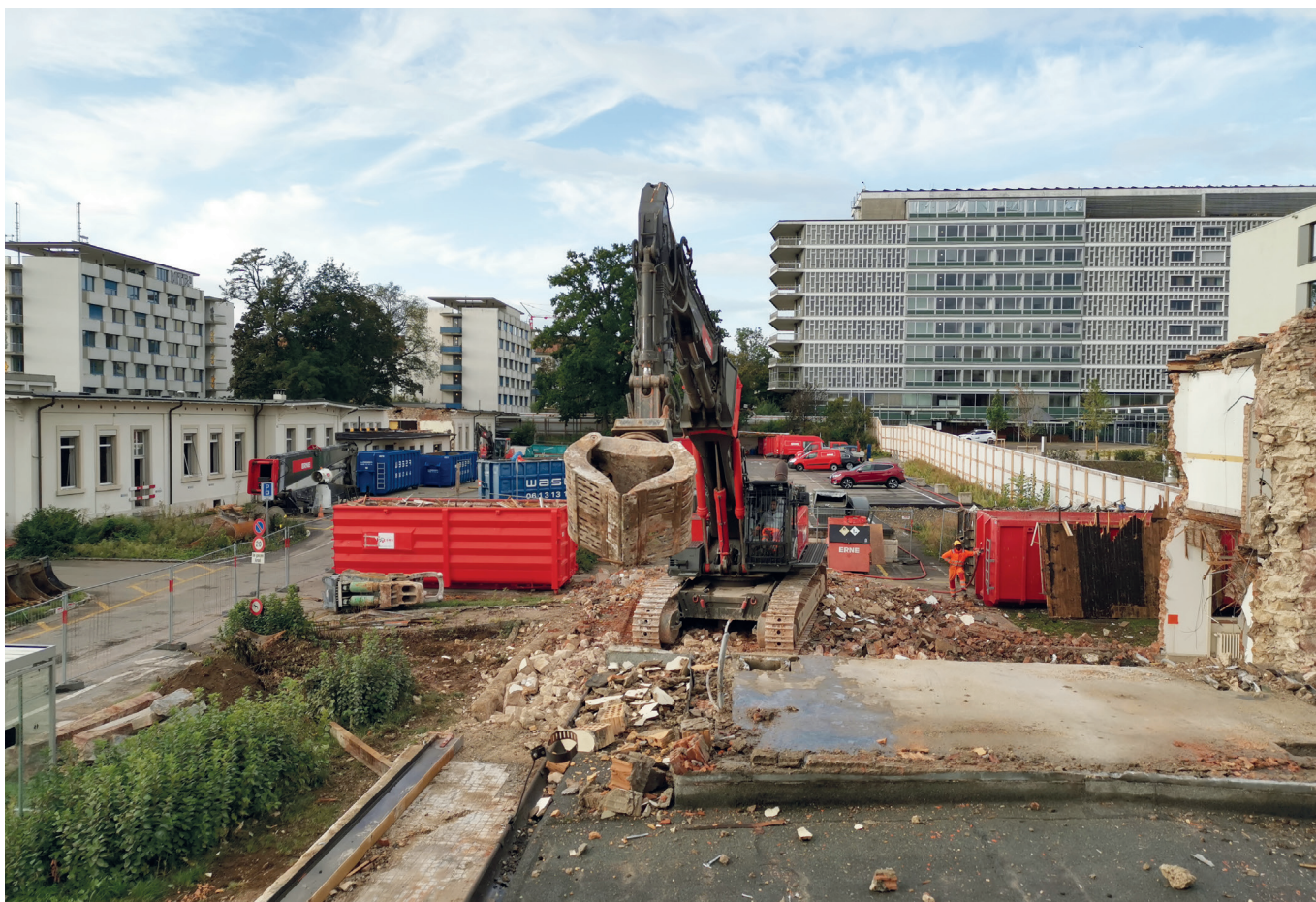
Mit dem Rückbau von Bestandesgebäuden durch den Kanton Basel-Stadt haben die Bauarbeiten auf dem Westfeld begonnen.
