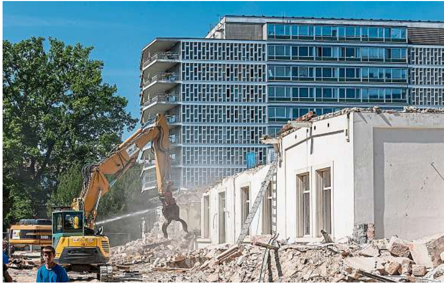
Abriss verhindert. Das 1967 erbaute Spital (im Hintergrund) wird ausgehöhlt und energetisch saniert, um 130 Wohnungen einzubauen. Foto Kathrin Schulthess
