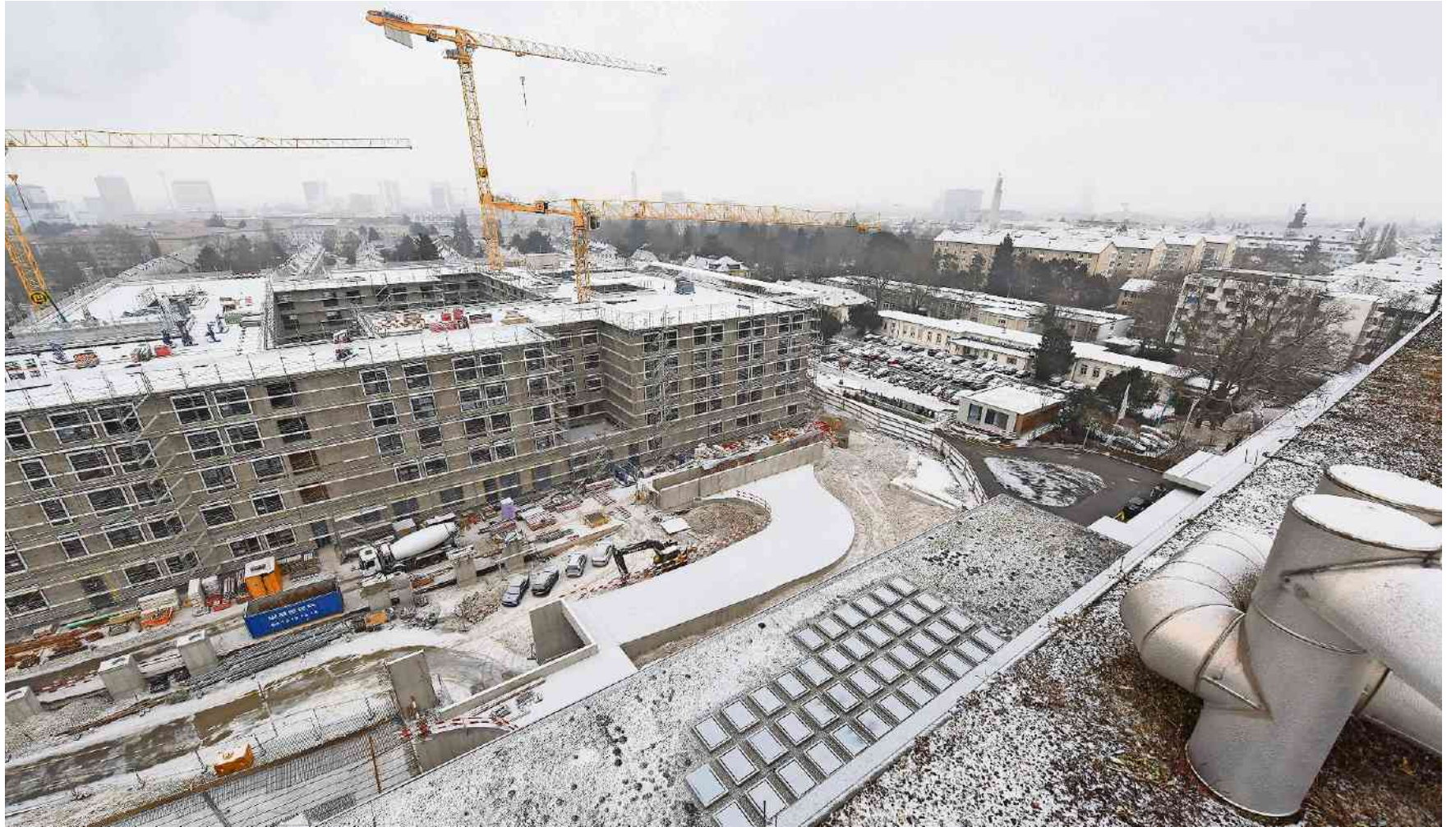
Hier geht die Post ab. Blick von der Dachterrasse des alten Felix-Platter-Spitals auf das neue, welches 2019 bezugsbereit sein soll. Auf dem Areal der einstöckigen Gebäude und auf dem Parkplatz kommen die sechsgeschossigen Neubauten zu stehen. Ganz rechts eines der beiden Personalhäuser.
