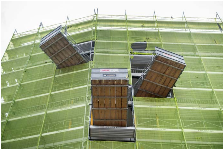
Auch der Zugang zu den zehn Geschossen ist eine Herausforderung: Diese temporären Plattformen können direkt vom Baukran aus angesteuert werden. Christoph Ruckstuhl / NZZ
