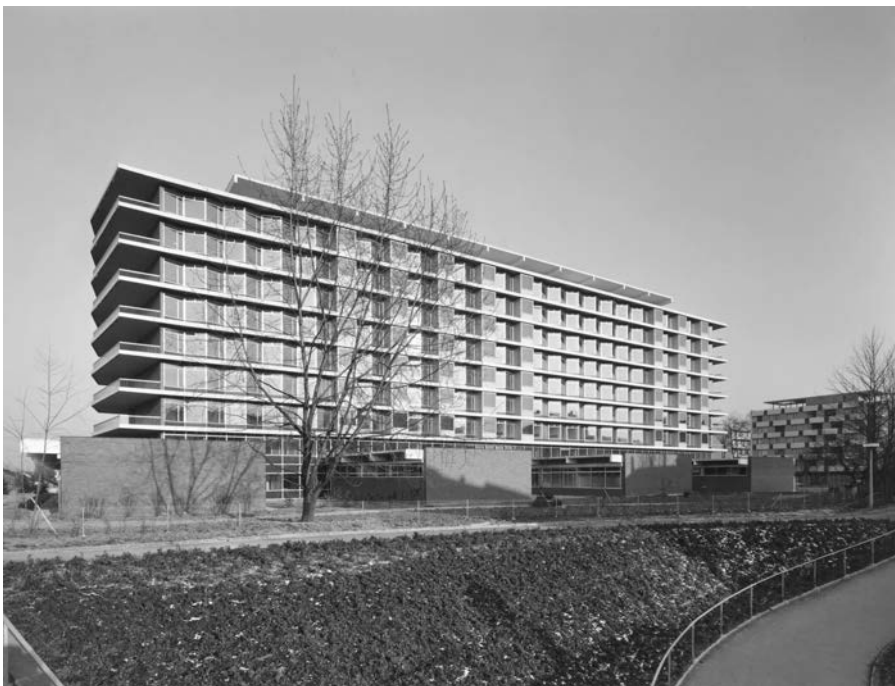
Die gefaltete Fensterfront an der Südwestfassade wird zur äusseren Haut der neuen Balkonschicht und kann so in ihrer ganzen Eleganz und Feinheit erhalten werden.
