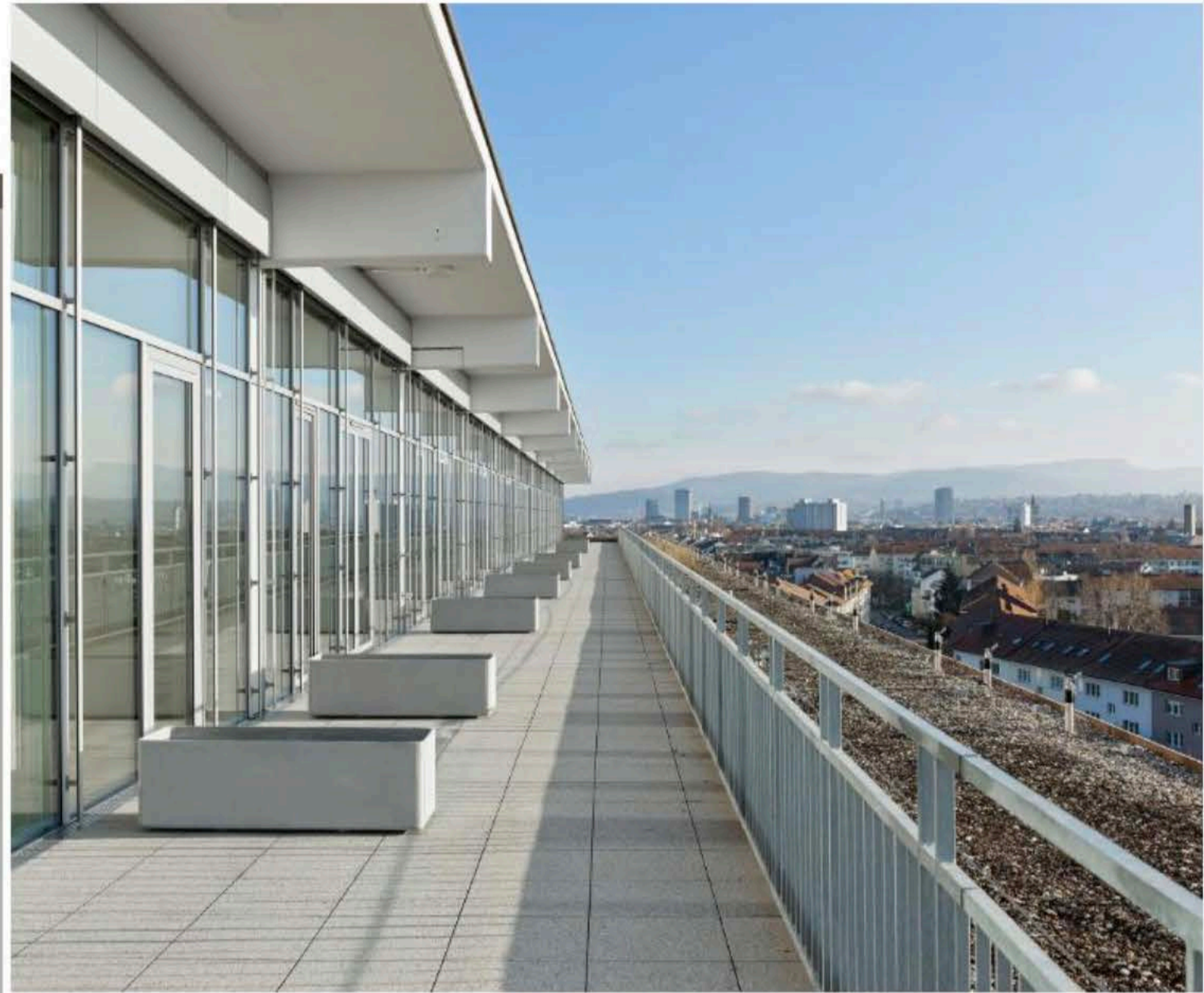
Die eingerückte neue Verglasung (links) ermöglichte den Erhalt der Metallfassade.
