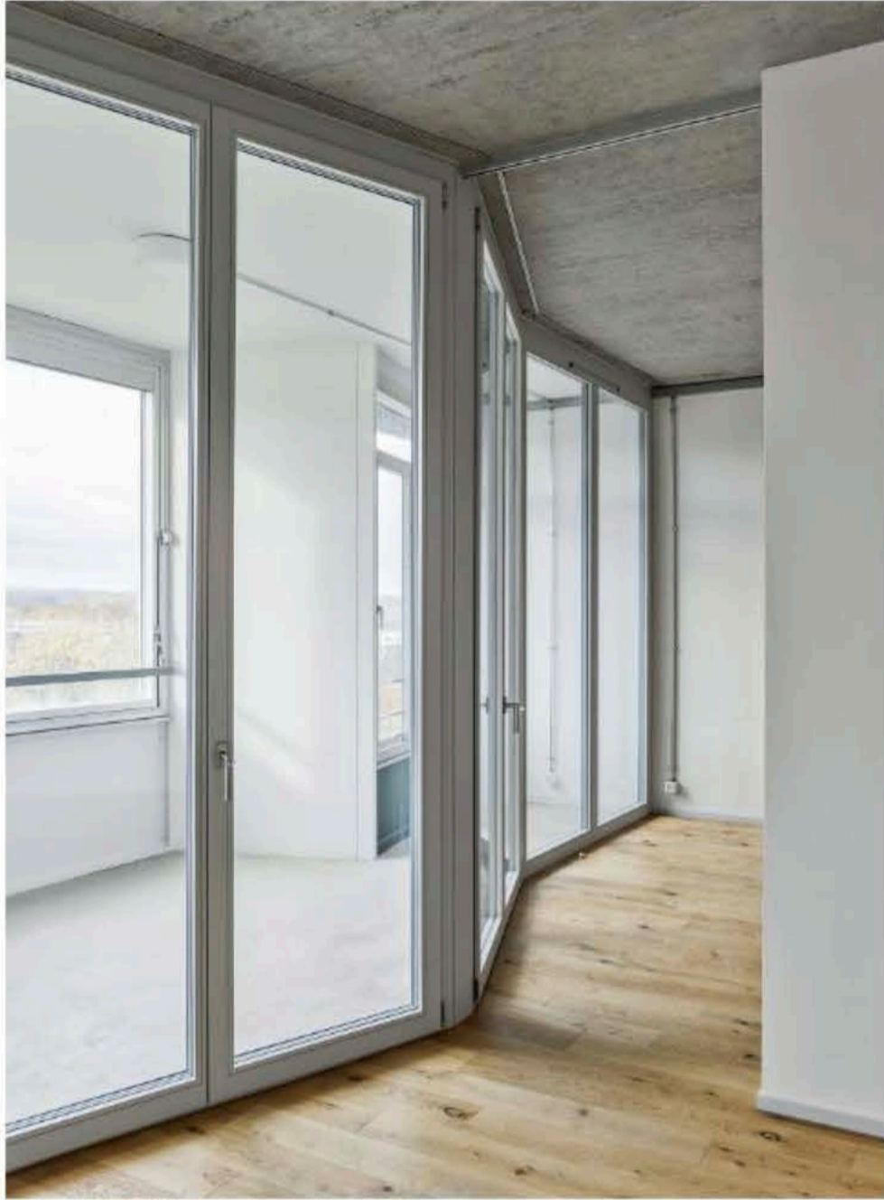
Die eingerückte neue Verglasung (links) ermöglichte den Erhalt der Metallfassade.
